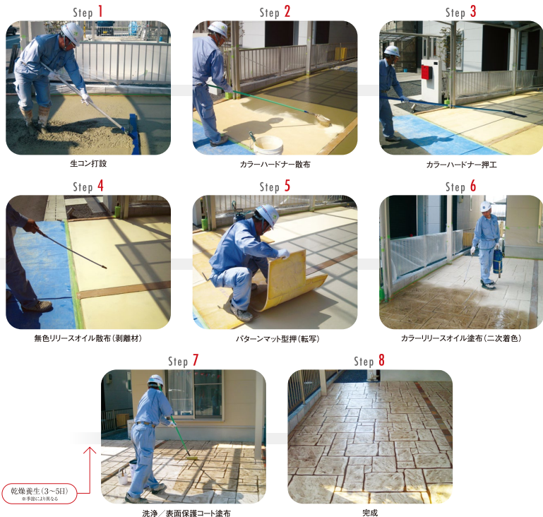
【スタンプコンクリート施工断面】
