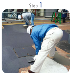
プライマー塗布(下地処理)
